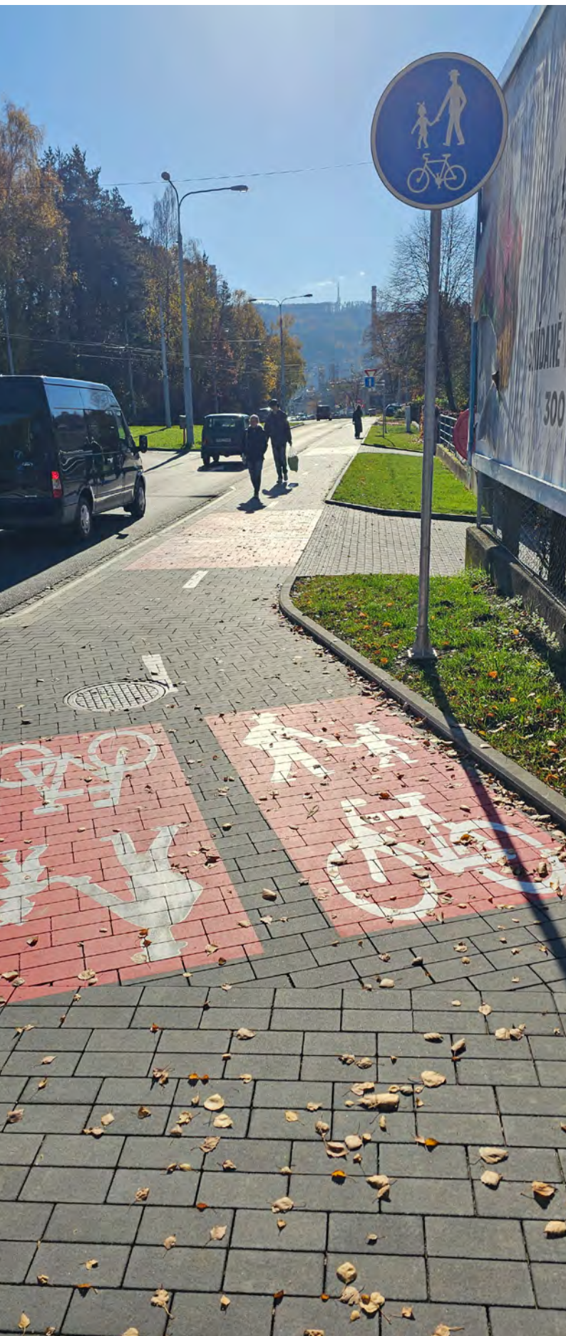
Stezka pro chodce a cyklisty, místní komunikace ul. K Pasekám
