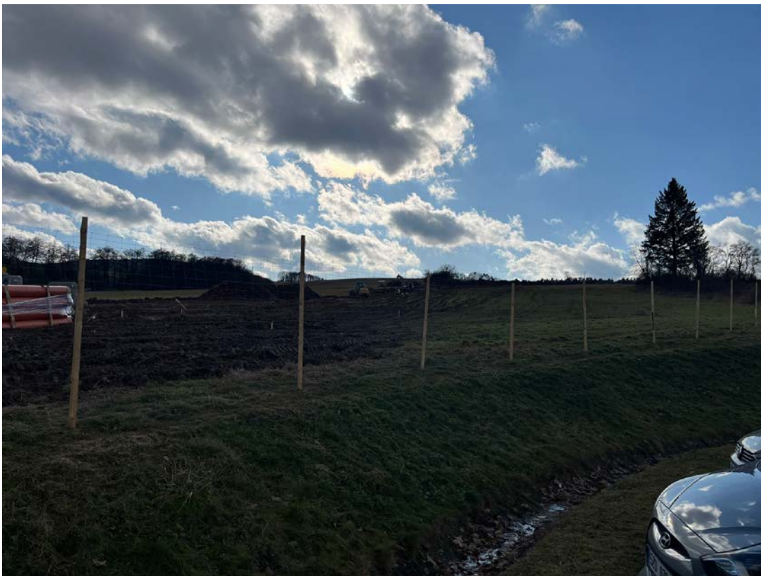
Na ploše BU č. 138 probíhá realizace
