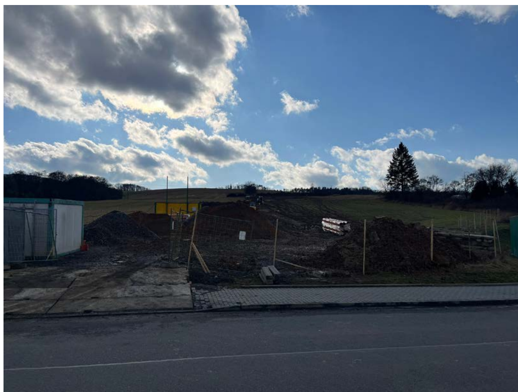
Příjezdová veřejná komunikace na ploše BU č. 138 je již v realizaci
