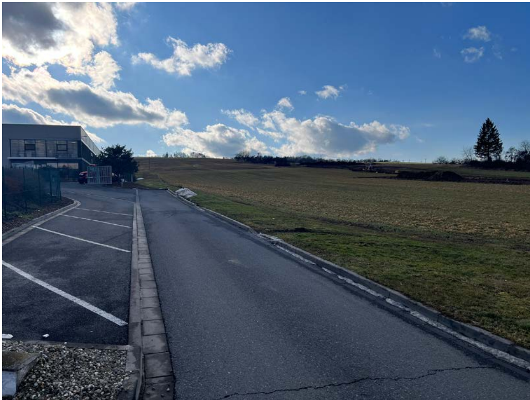
Příjezdová komunikace od ulice 4. května
