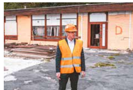
Primátor Jiří Korec ve Šmoulím městě na začátku demolice
