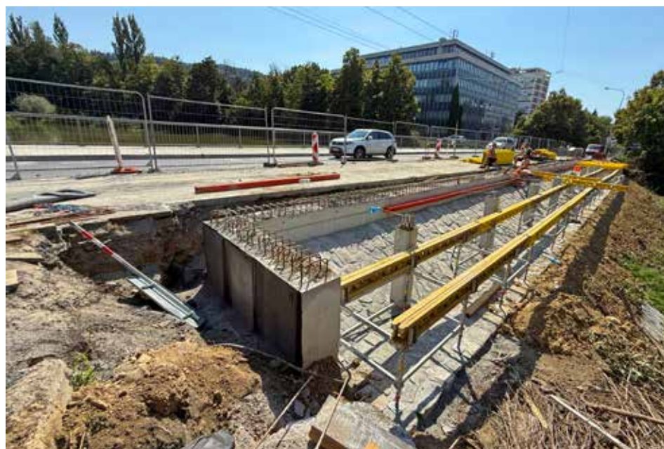
Ke klíčovým dopravním stavbám patří také oprava mostu u Kudlovské přehrady.
