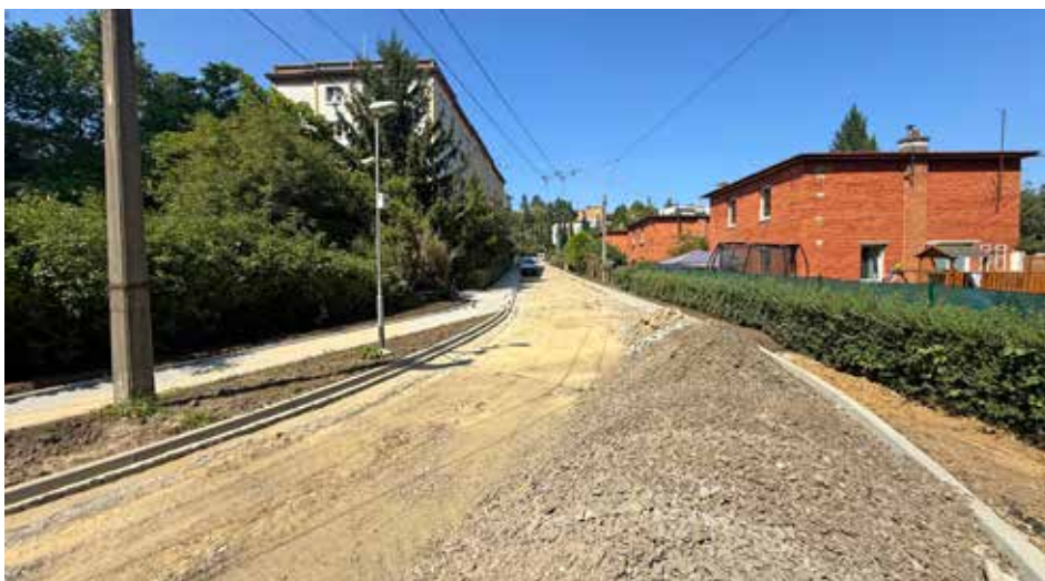
Ulice Padětky IX je důležitou spojkou mezi ulicemi 2. května a Sokolská. Oprava frekventované silnice byla nutná, povrch byl na řadě míst v dezolátním stavu.
