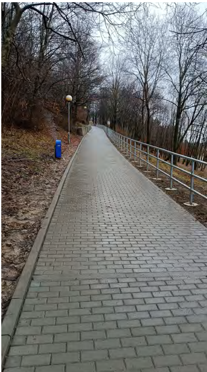
Oprava chodníku z Čepkova na ul. Nad Stráněmi
