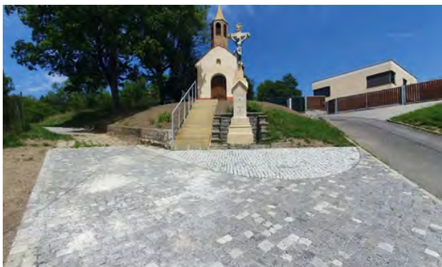
Venkovní úpravy okolí Kaple Panny Marie ve Zlíně
