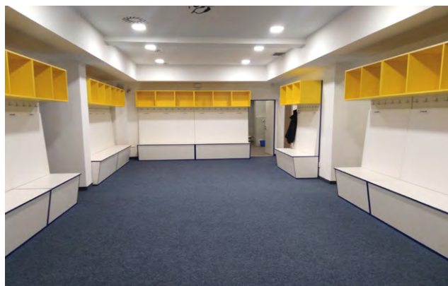
Stavební opravy - šatna AA
