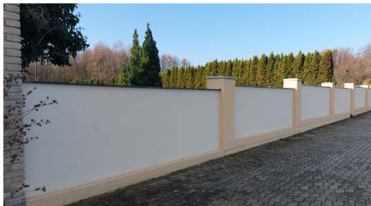
Hřbitov Mladcová - opravené oplocení
