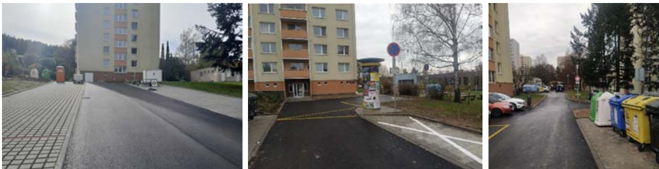
Regenerace panelového sídliště Zlín - Podhoří
