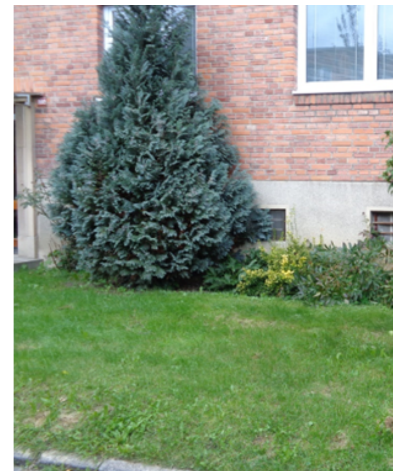
↑ Nevhodné dřeviny v blízkosti fasád
