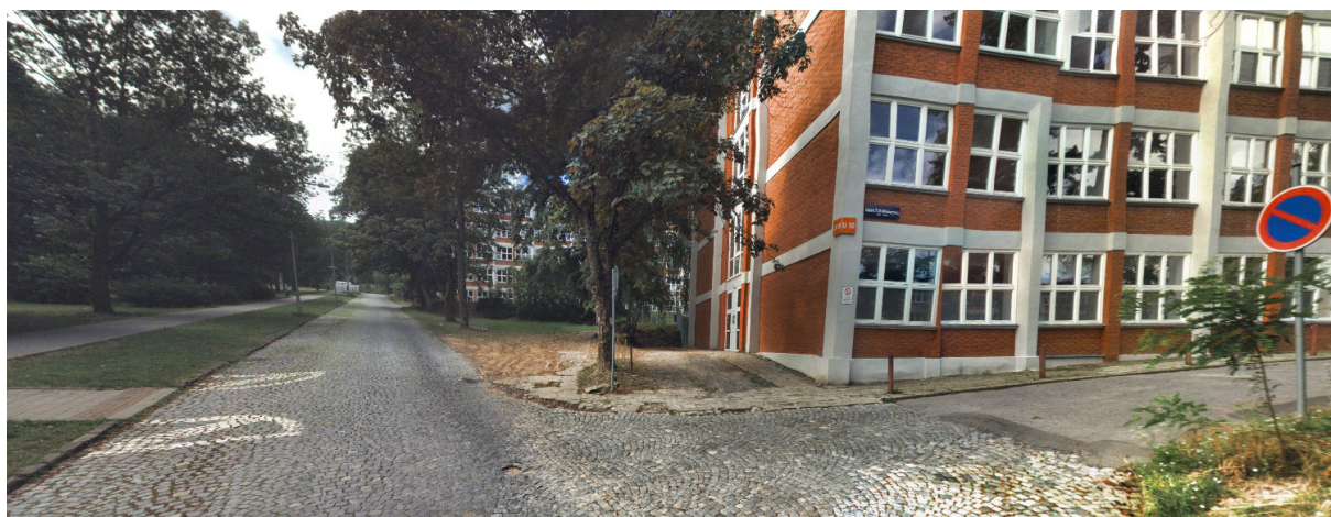
Obr. 87 Chybějící chodníky (Nad Ovčírnou), přechody a narušený povrch chodníků a ploch pro pobyt v okolí škol. Zdroj: Mapy.cz (2019)
