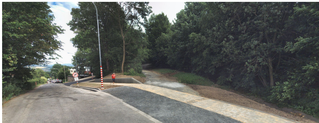
Obr. 28 Probíhající úprava komunikace Lesní čtvrť II - Kudlov pro chodce. Zdroj: Mapy.cz
