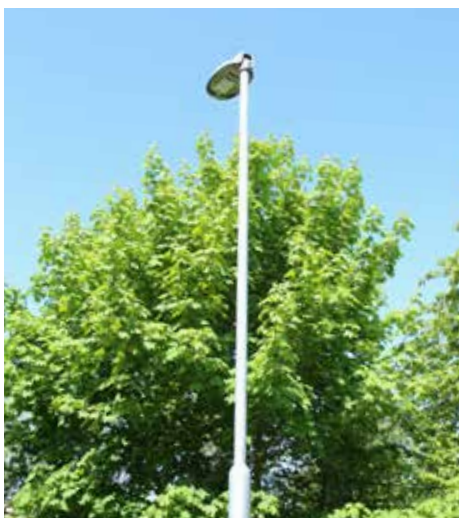
Rekonstrukce veřejného osvětlení – Bartošova čtvrť – zrealizováno
