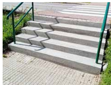
Údržba a opravy schodů a chodníků – Sokolská – zrealizováno
