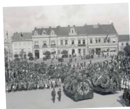
Choreografii průběhu pohřbu byla věnována velká pozornost. Průvod přicházel na náměstí z Bartošovy ulice a na jeho ploše byla přesně vymezena místa pro účastníky i přihlížející. Foto: Josef Vaňhara. Zdroj: SOkA Zlín, fond Sběrka fotografií Zlín, obálka č. 259, poř. č. 1.
