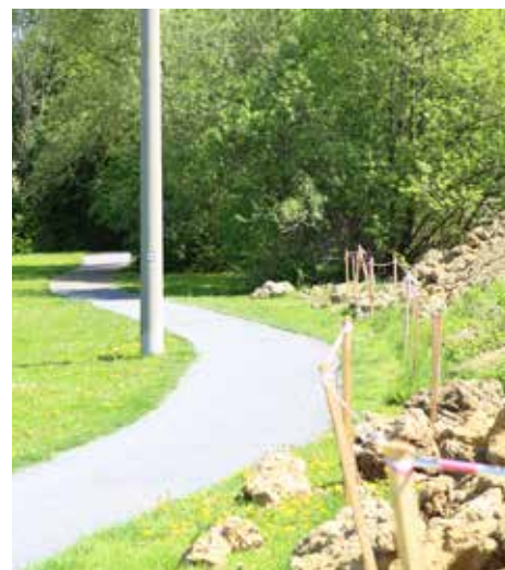
Vybudování zpevněné stezky v lokalitě Kocanda – točna směr bývalá Koliba – zrealizováno
