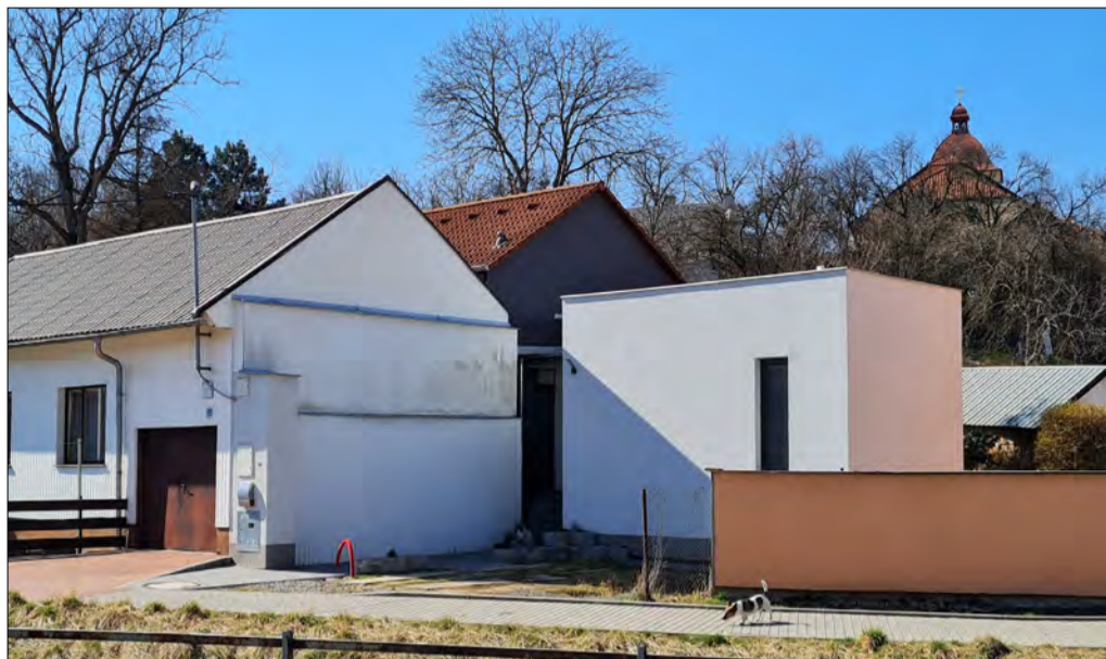
Švermova 190 („kostka“ + fialová budova v zákrytu)
