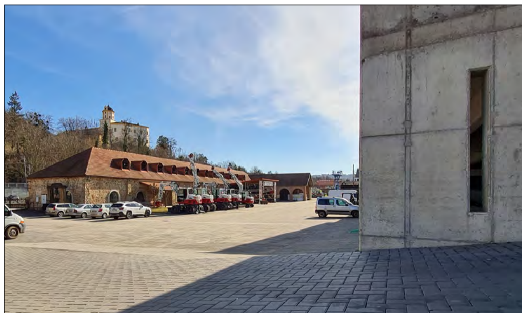
Žleby 95 — od severozápadu
