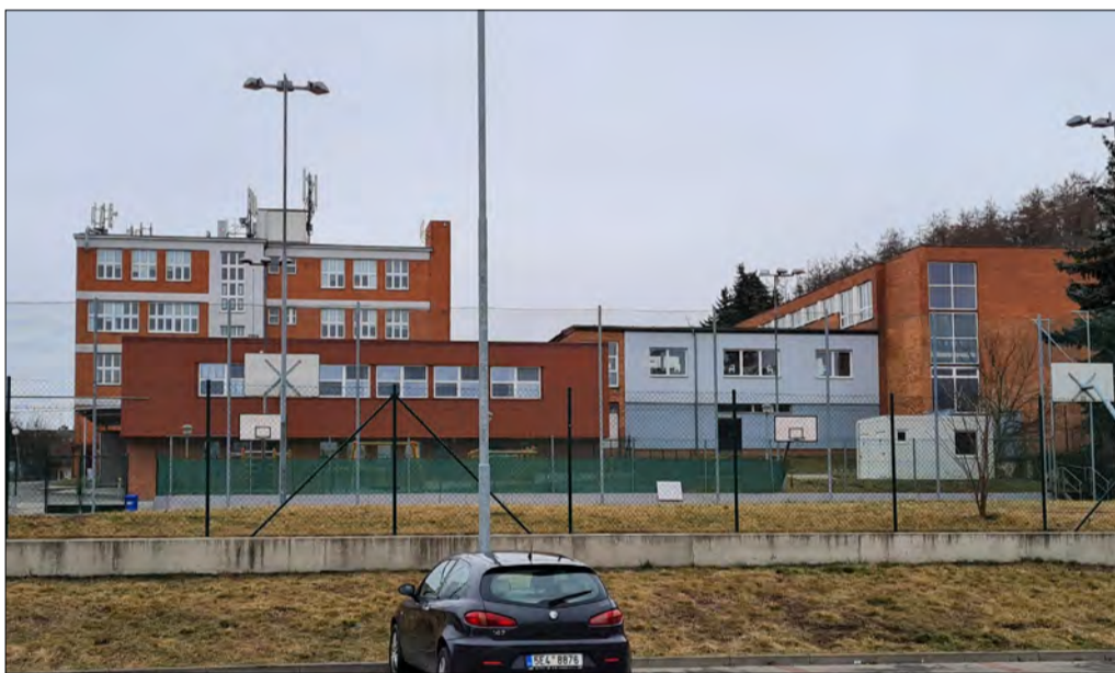
Komenského 78 — ZŠ (pohled z ulice Švermova)
