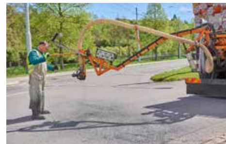
Pracovník TS opravuje cestu pomocí technologie TURBO
