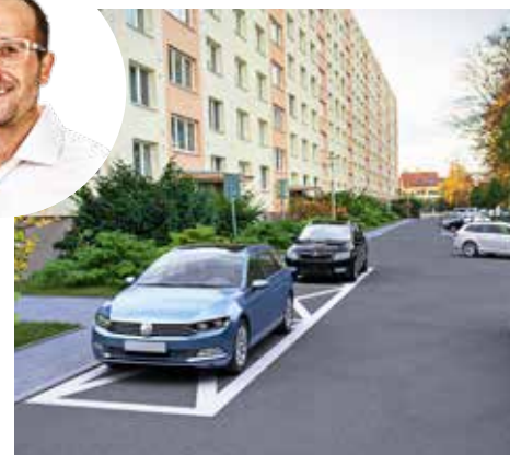
Zrekonstruovaná vozovka u bytového domu
