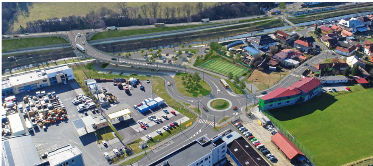
Finální vizualizace nového silničního napojení průmyslové zóny na Příluku na silnici I. třídy (ŘSD ČR)
