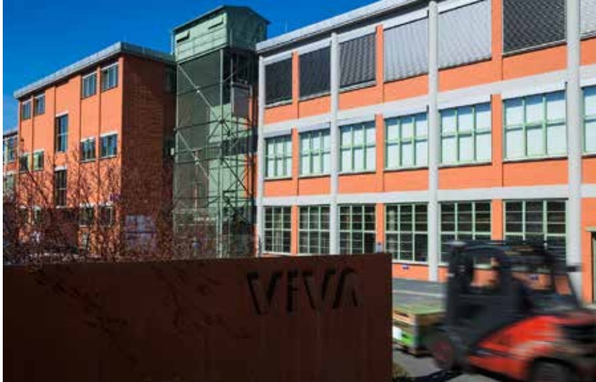
Sídlo společnosti v rekonstruované budově 74
