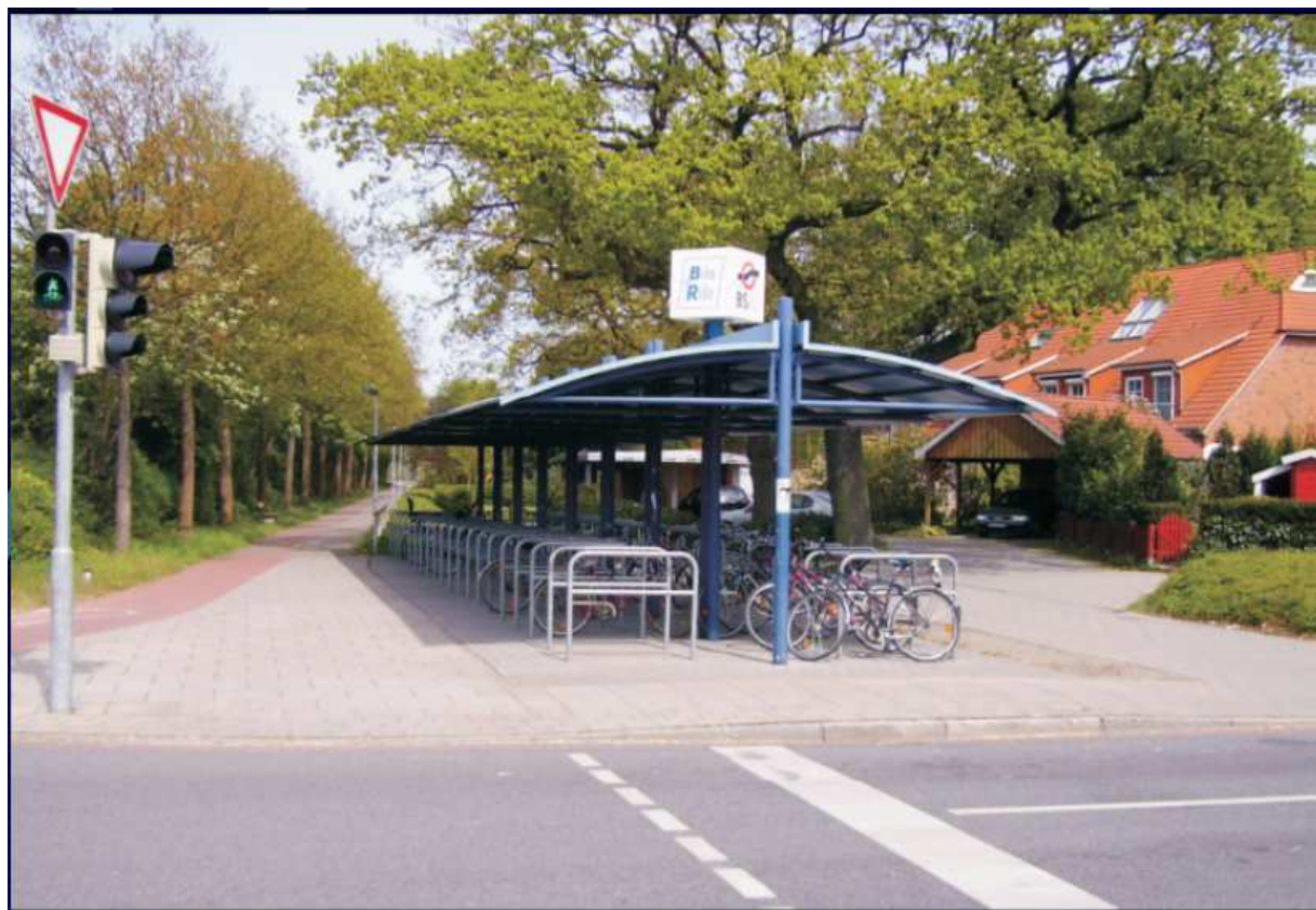
Obrázek 29: Příklad úschovny kol u dopravního terminálu s kapacitou 100 kol, náklady zhruba 1 mil. Kč
