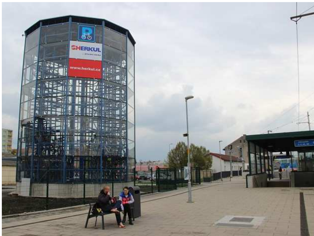
Obrázek 30: Příklad parkovacího domu kol u nádraží Přerov s kapacitou 118 kol, náklady zhruba 10 mil. Kč
