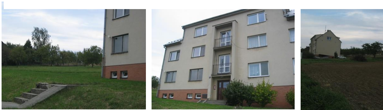
Plocha č. 1, stávající bytovka a plocha č. 2
