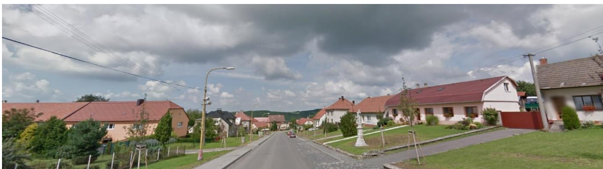
Původní, historická (řadová) zástavba včetně veřejného prostoru
