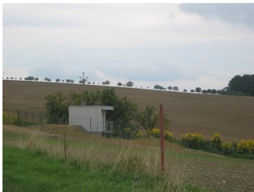
Vodojem (přerušovací komora) pro obec Dobrkovice
