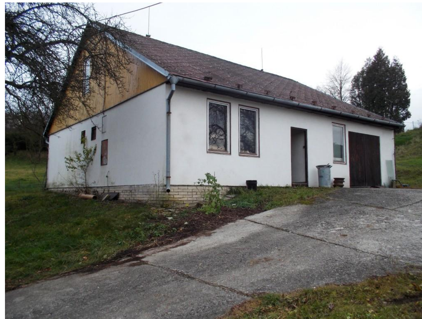
Obr.7 – Pohled na řešené území z ulice Václavská – objekt občanské vybavenosti č.p. 360
