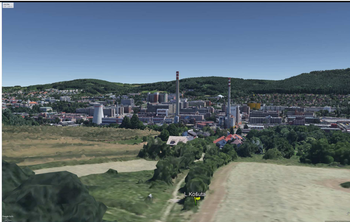
8. Pohled z vyhlídky nad ulicí L. Košuta k centru Hmota výškové úrovně 1
