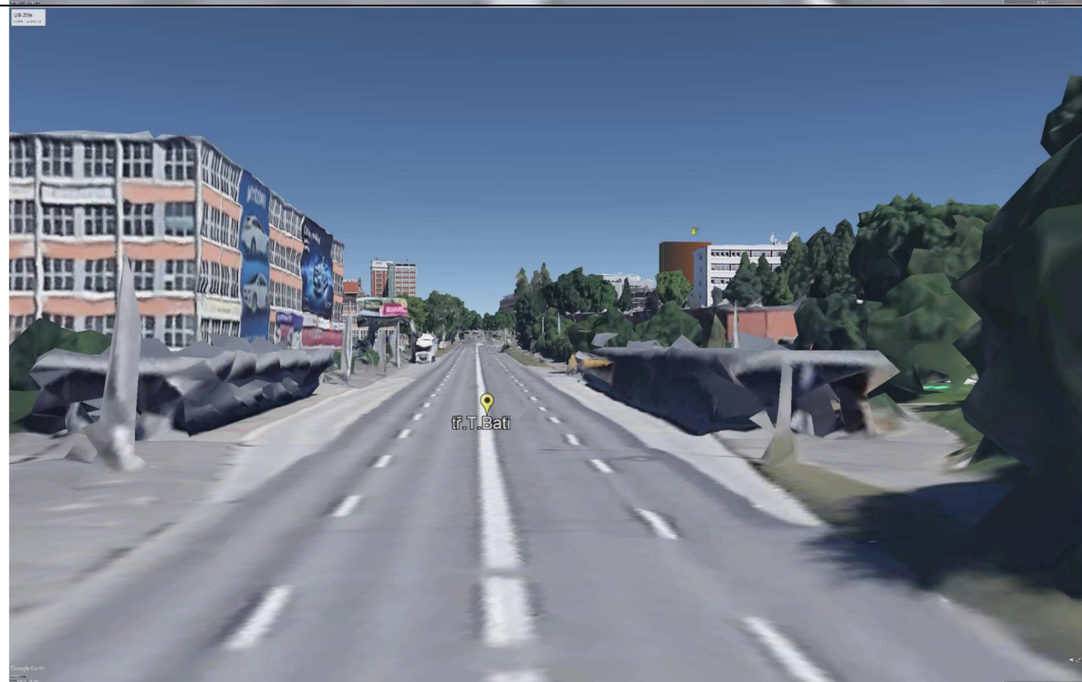
1. Pohled třídou Tomáše Bati k centru Hmota výškové úrovně 1 a 2
