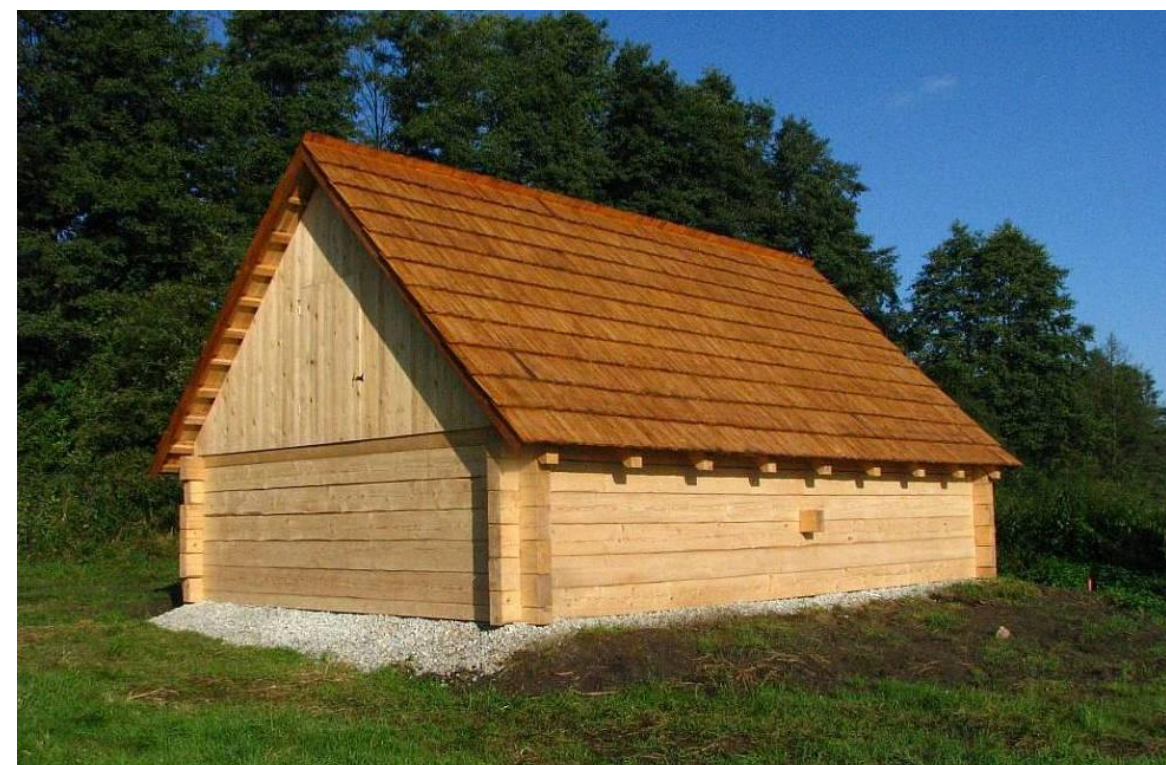
obr. 15, vhodný příklad - Nově opravený seník na Mokřích lukách v Třeboni.
