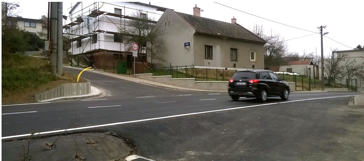
Rekonstrukce křižovatky v Kostelci
