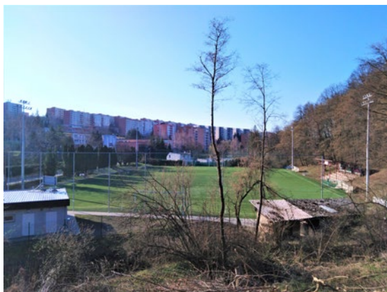
Osvětlení fotbalového hřiště Zlín - Paseky
