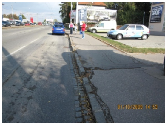
Zastávka MHD Růžová - Zlínská vodárenská (současný stav)
