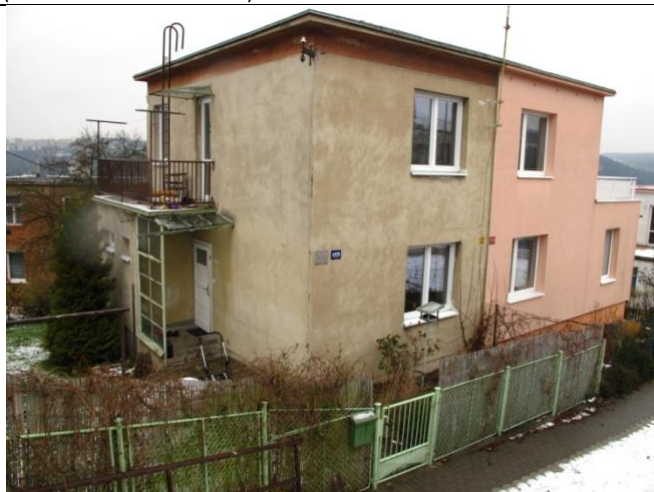
Dům před rekonstrukcí v roce 2017, měl hodně původních detailů (vstupní dveře, vnitřní dveře, podlahy), pouze okna byla vyměněná za plastová
