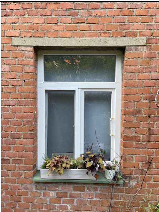
Nové okno z europrofilů, s fixní vrchní částí (kvůli zúžení vodorovného profilu), spodní křídla otvíravá, na ventilačním křídle je instalována síťka proti hmyzu
