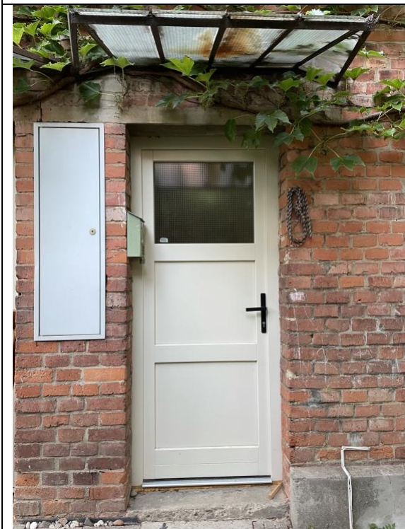
Vstupní dveře dělené na tři část, s částečným prosklením
