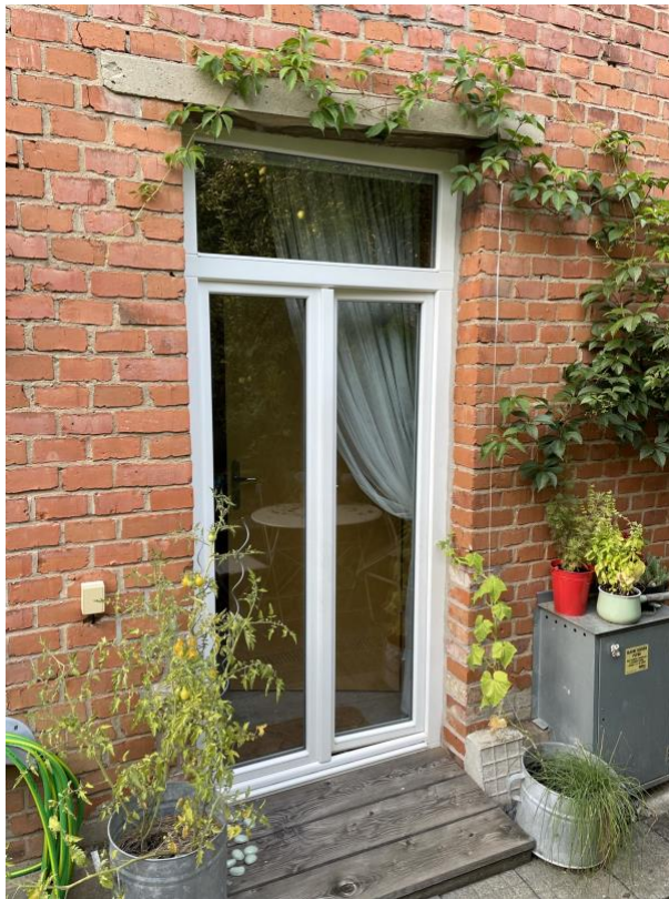
Snížení parapetu okna u čtrtdomku (francouzské dveře) pro výstup na zahradu
