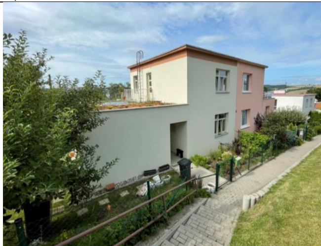
Dům po rekonstrukci v roce 2021 (dokončují se exteriéry), byla provedena přístavba a zateplení domu, okna jsou z europrofilů a přepisují původní členění
