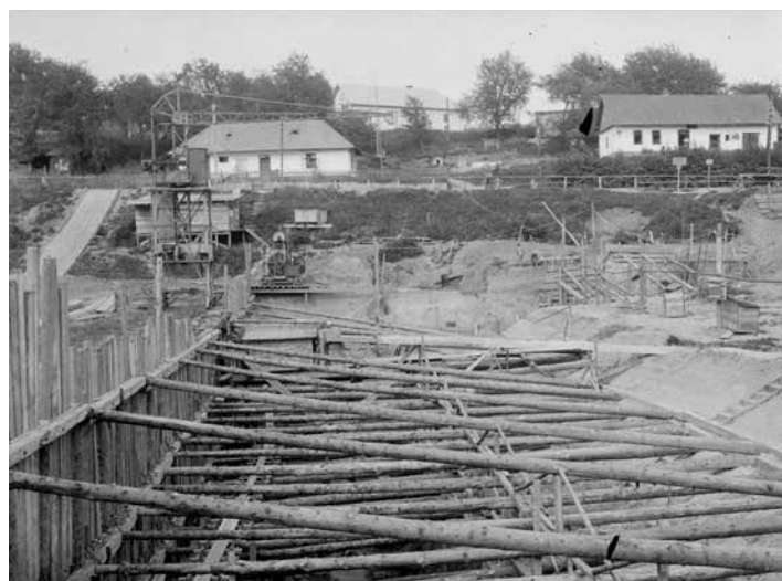
Ze stavby Fryštácké přehrady – výkopy pro základy hráze. SOKa Zlín
