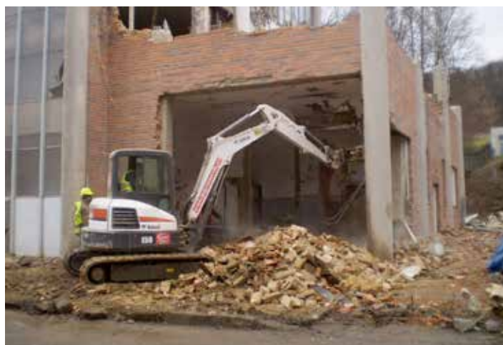
Demolice přístavku. / foto: archiv
