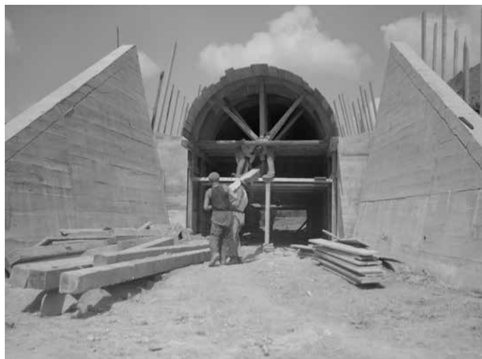
Fryštácká přehrada – stavba betonové propustě u hráze dolnoveského výběžku. SOKa Zlín
