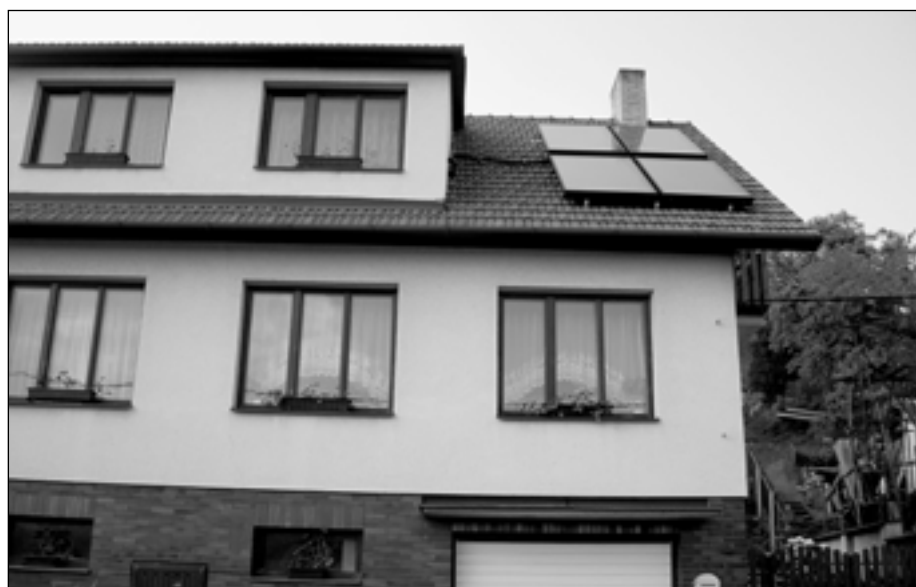
Dům manželů Mašláňových v Loukách s kolektory na střeše.
