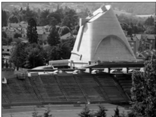
Dostauba kostela Saint-Pierre a sportovní stadion - komplex staveb od architekta Le Corbusiera ve Firmini, Francie.
