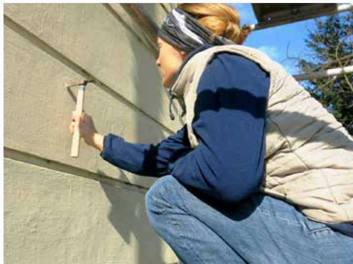
Zjišťování původní barvy fasády. / foto fab
