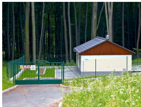
Čistírna odpadních vod Salaš / foto: Ivo Hercík
