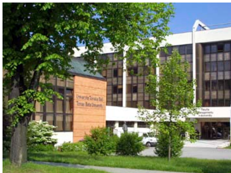
Budova univerzity na Mostní ulici / foto: archiv MMZ
