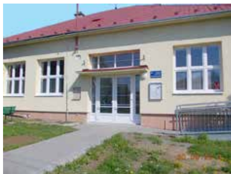
Rekonstrukce objektu v MČ Salaš. / foto: archiv
