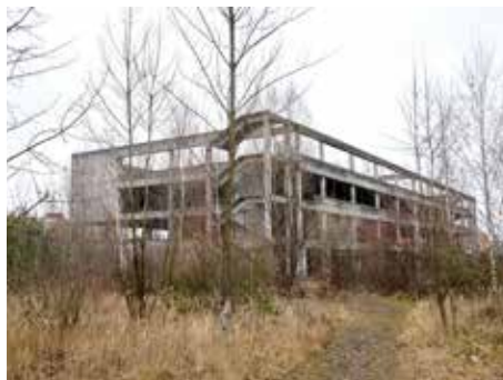
Demolici již nic nebrání. / foto: IH
