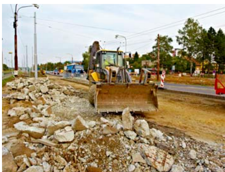
Rozšiřování silnice I/49 v Malenovicích / foto: Ivo Hercík
