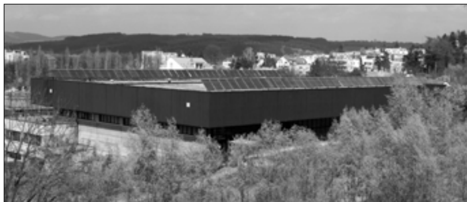
Solární kolektory na střeše haly Městských lázní.
