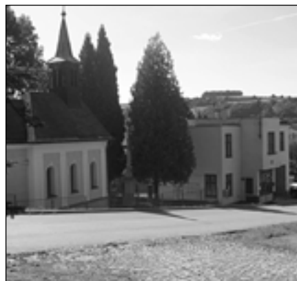
Kancelář místní části Příluky a kaple sv. Martina.
