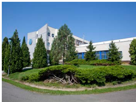
Úpravna vody v Klečůvce. / foto: D. Bachůrek
