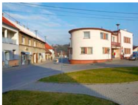
Želechovice nad Dřevnicí / foto: Ivo Hercík
