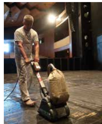
Odstraňování 19 nátěrů. / foto: MDZ
