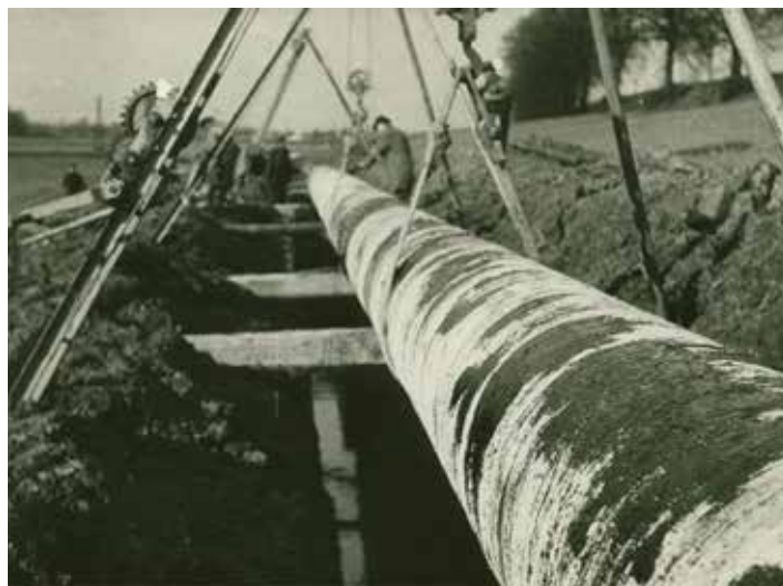
1949 – stavba úpravní vody v Tlumačově. / foto: SOkA Zlín
