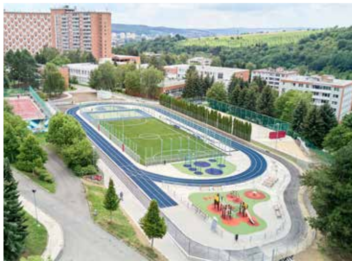
Rekonstrukce areálu sportoviště u ZŠ Okružní. / foto: archiv
