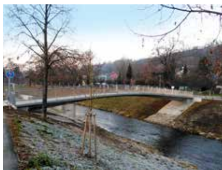
Lávka je hodně využívána. / Foto: MMZ
