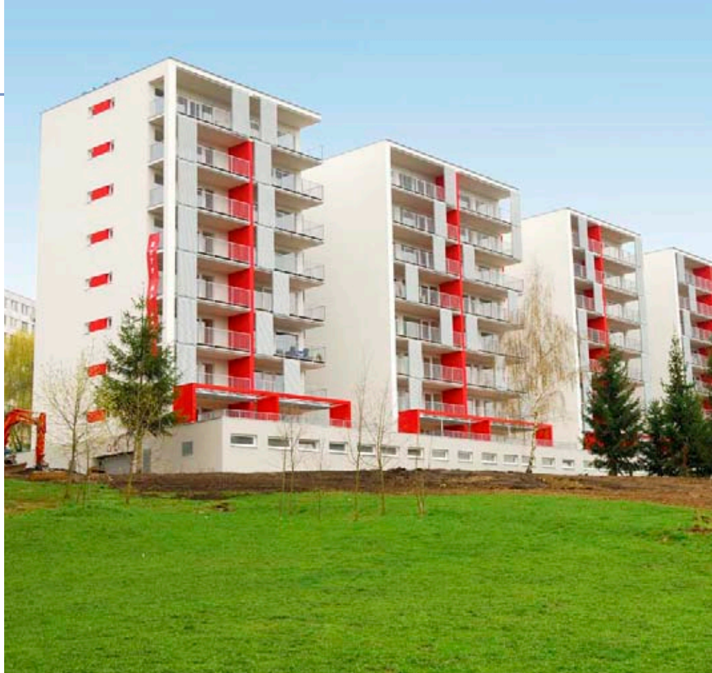
Bytový dům Zlín - Křiby / foto: archiv soutěže
