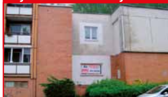
Ubytovna Zlín - Jižní Svahy N04715
