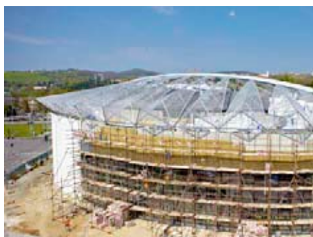
Stavba je v plném proudu / foto: Ivo Hercík
