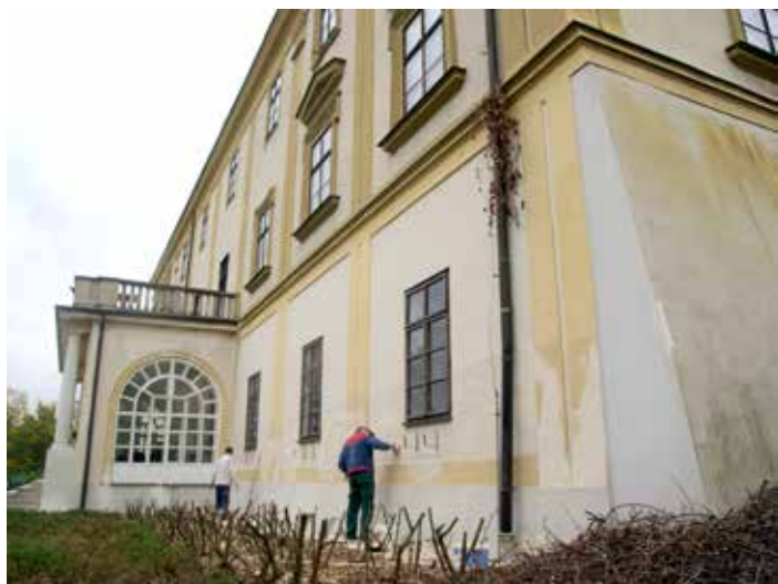
Opravují se praskliny a chybějící omítky. / foto: fab
