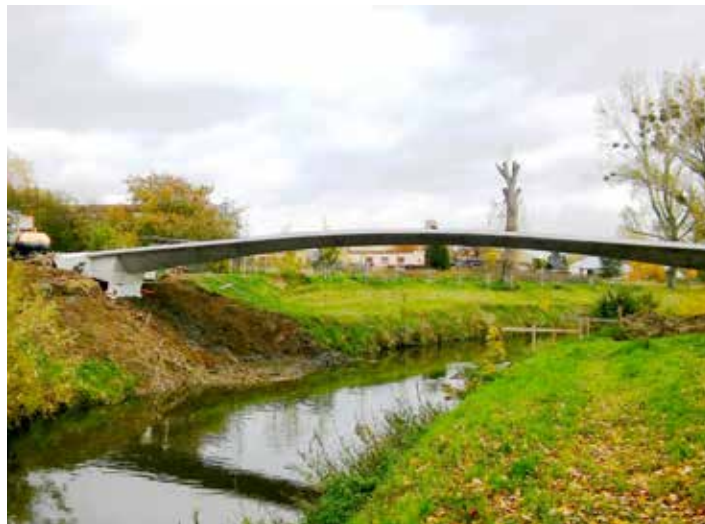
Lávka přes Dřevnici. / foto: archiv
