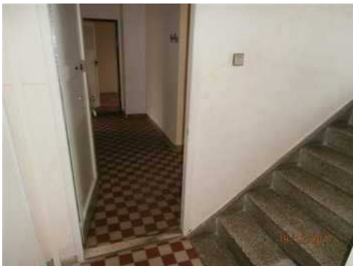
schodiště, chodba bytu
